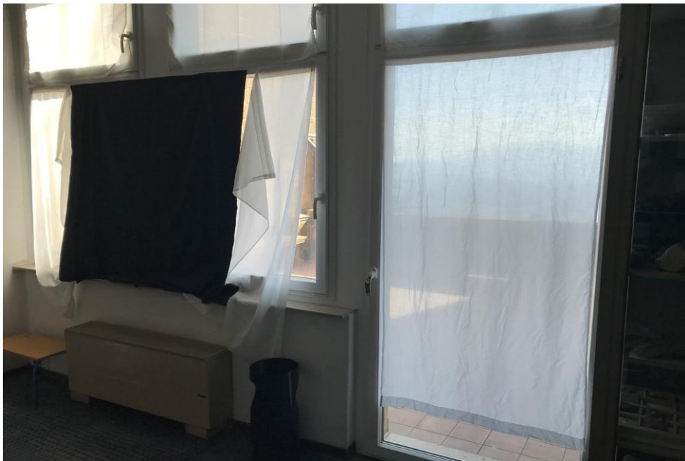
Area corridoio finestre porta finestra prospicienti il terrazzo.
