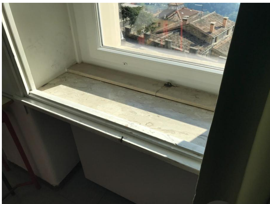
Tipologia delle tende esistenti presenti nelle aule didattiche al piano primo sottostante Cod. A1.
