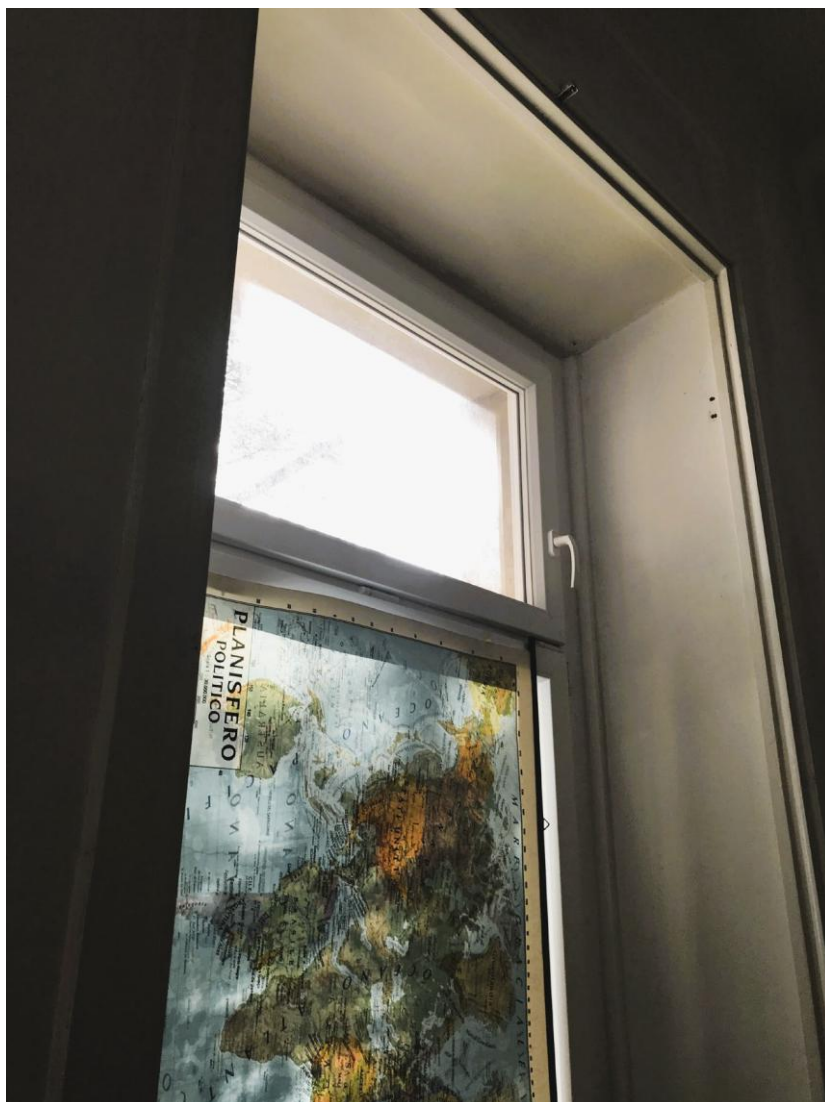
Aula al piano primo sottostante Cod. A1.
